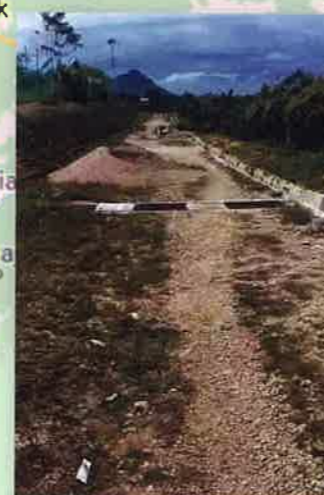
右側が増設した水路
