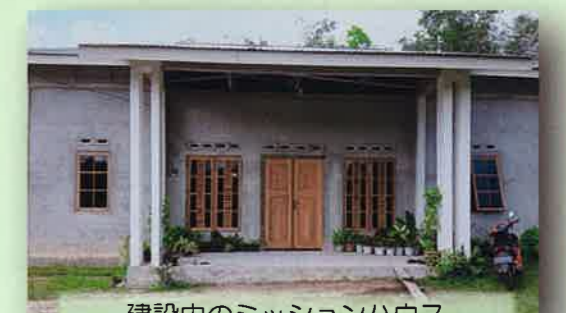
建設中のミッションハウス
